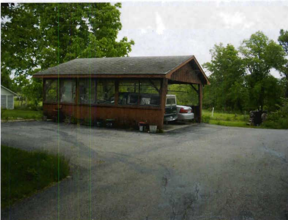
Structure 9c (Carport), view ENE
