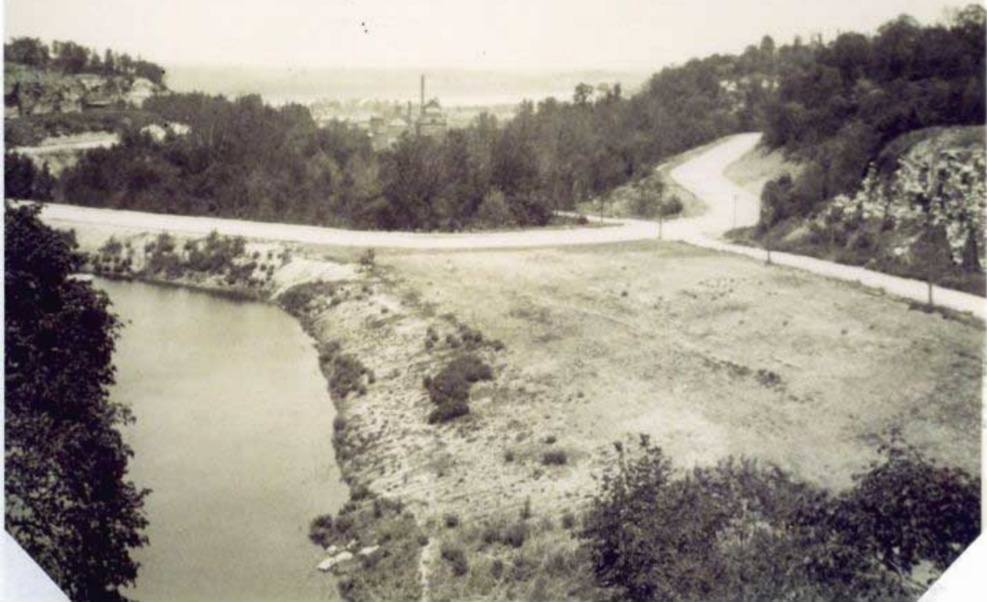
K-21 Chestnut Av. Viaduct looking N. 1907
